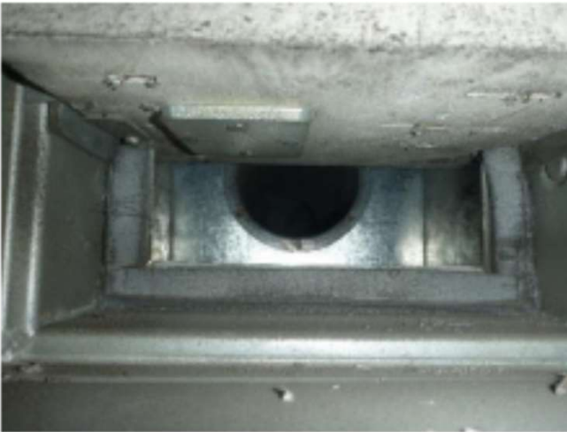
Abbildung 8: Typische Bilder bei einem guten Zustand der BSK
