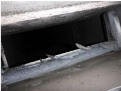
Abbildung 6: Typische Schadensbilder bei einem schlechten Zustand der BSK
