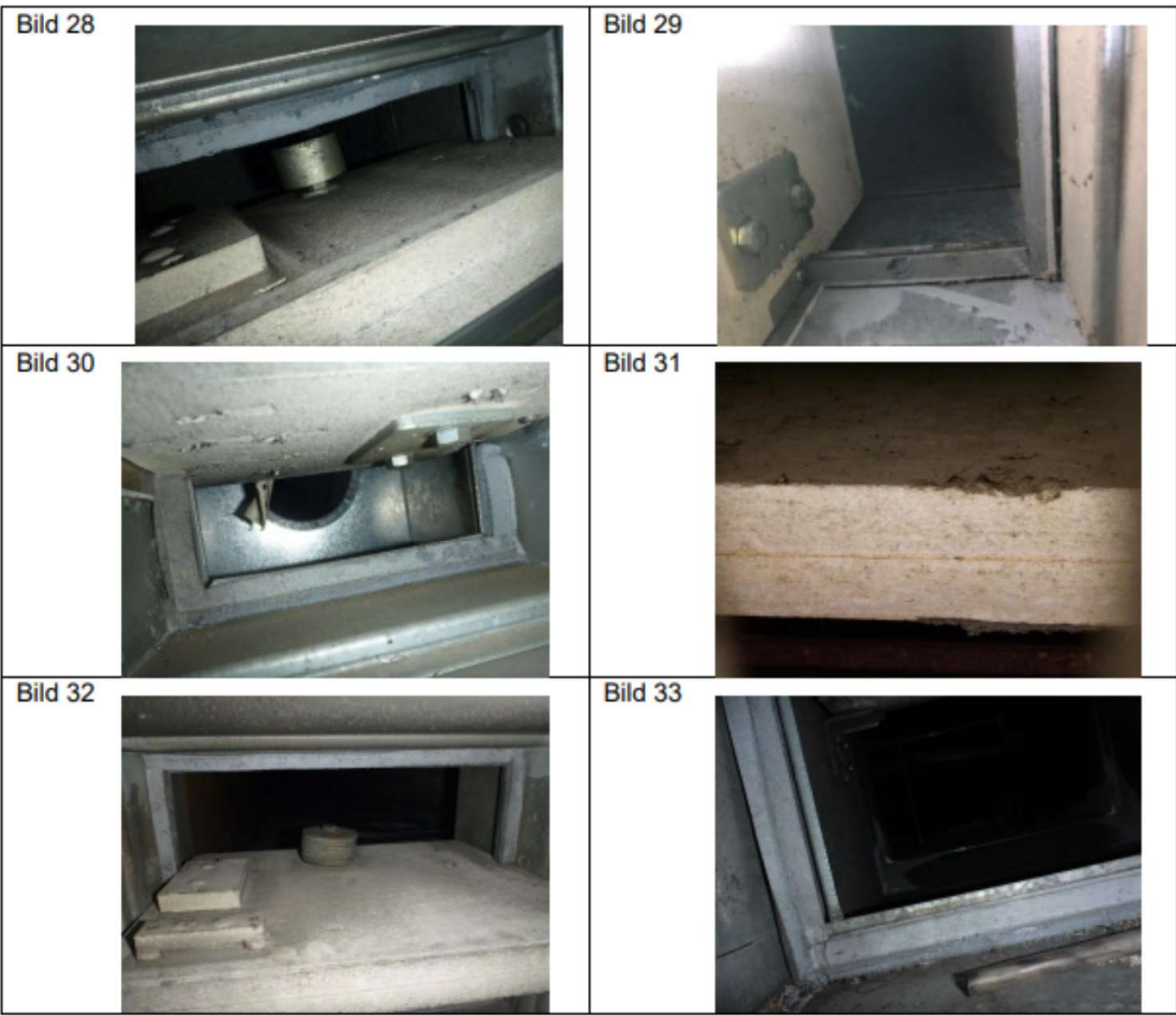
Abbildung 7: Typische Schadensbilder bei einem mäßigen Zustand der BSK
