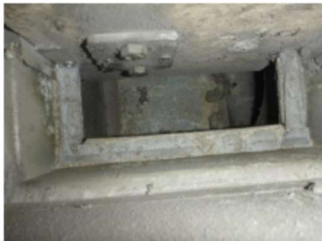
Abbildung 6: Typische Schadensbilder bei einem schlechten Zustand der BSK
